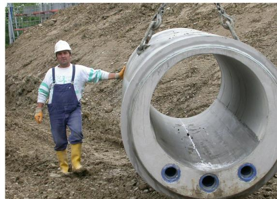
Kanalelement mit Wärmetauscher
