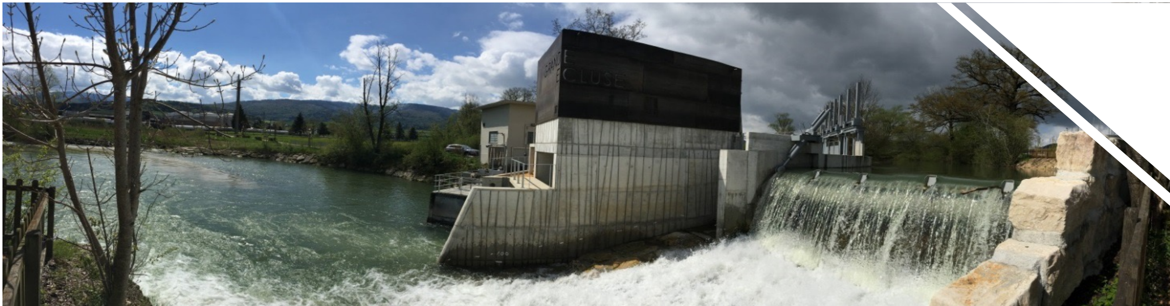
Centrale hydroélectrique de la Grande Ecluse
